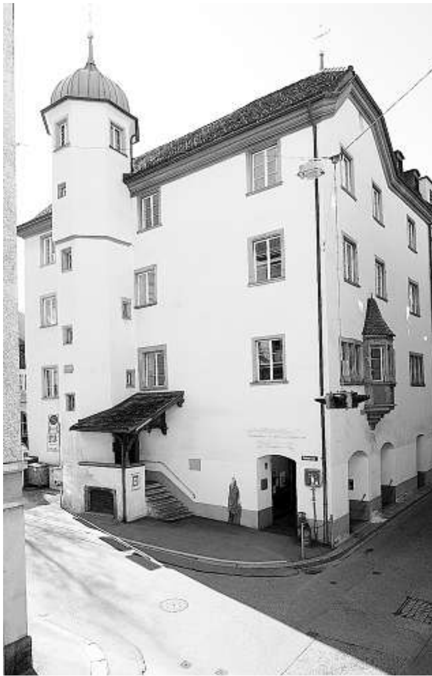
Auf in eine neue Zukunft: Die Realisierung des Familienzentrums Planaterra in Chur ist in vollem Gange. Bild Marco Hartmann
